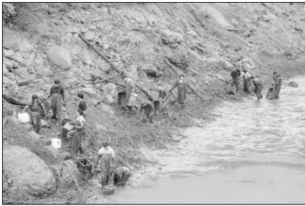
▲ため池での作業の様子
