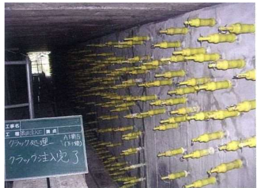
写真4-2 ひび割れ注入状況
