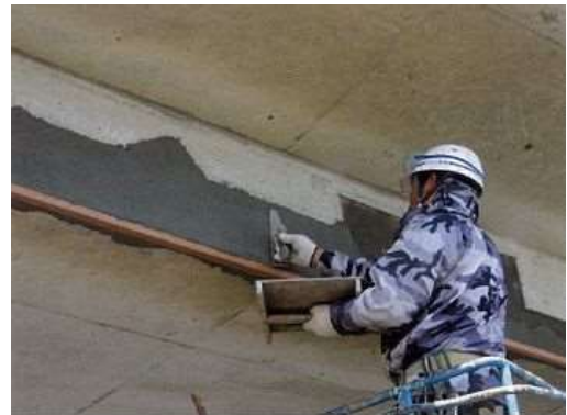
写真4-3 断面修復状況
