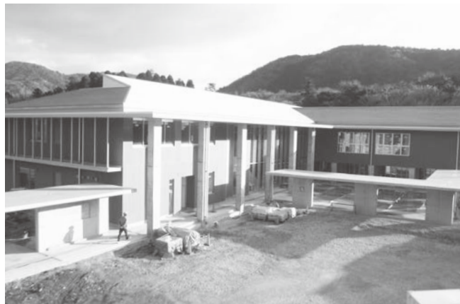
▲ 建設中の新庁舎（令和3年3月撮影）
