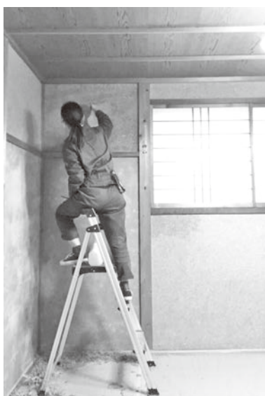
▶ 空き家の改修作業の様子。初めて壁に漆喰を塗る作業に挑戦しました!
