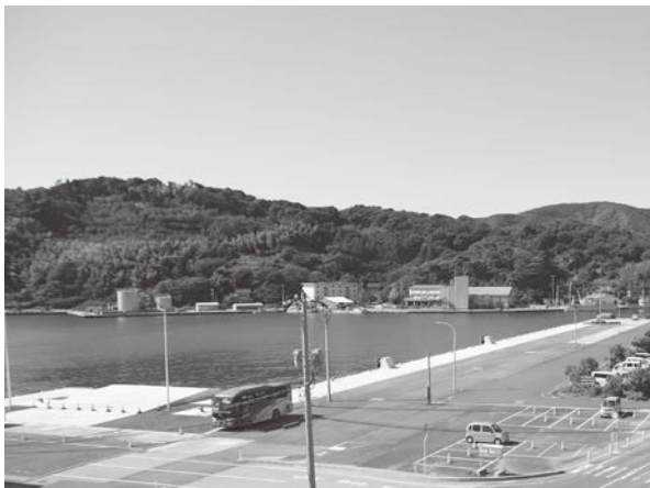
整備された耐震強化岸壁
