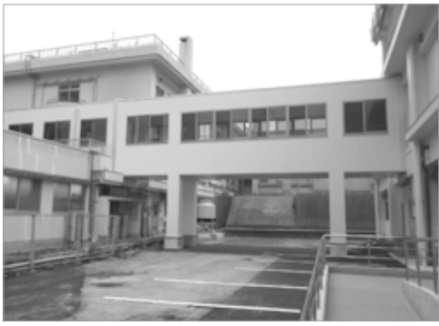
既設病院側と今回の施設は渡廊下でつながりました。
