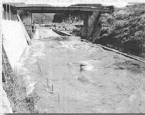
▲昭和58年5月26日に発生した津波の様子（船引運河）
