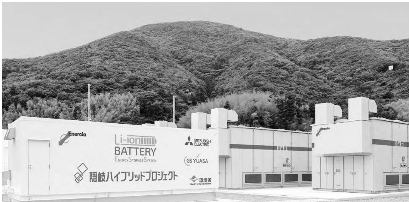
左側がリチウムイオン電池で右側がNAS電池。異なる蓄電池を組合せることで、再生エネルギーを安定して利用することが可能に。
