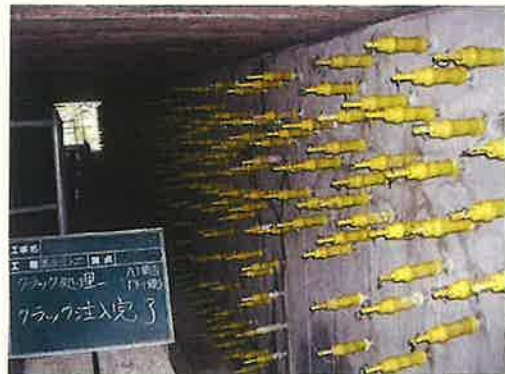
写真 4-2 ひび割れ注入状況
