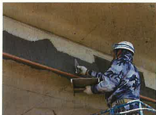
写真 4-3 断面修復状況
