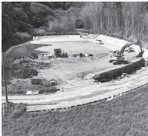
▲ 火葬場建設地 (令和8年8月時点)
